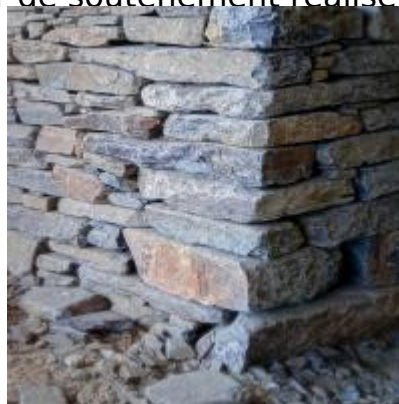
Mur de soutènement réalisé pour le
