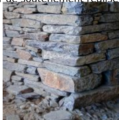
Mur de soutènement réalisé pour le
